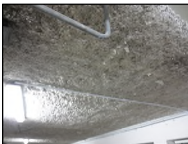
Photo N° 585 ECH-N°1 FLOCAGE -- Parking Plafonds Blanc cotonneux
